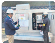
竣工検査状況
