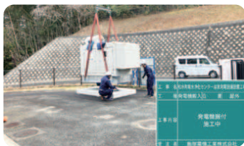
発電機据付状況
