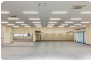
空調室内機設置
