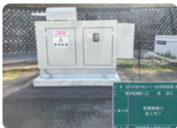
発電機据付完了状況
