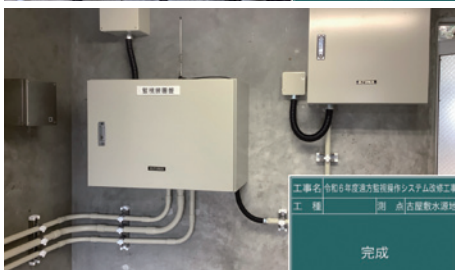
古屋敷水源地 完成
