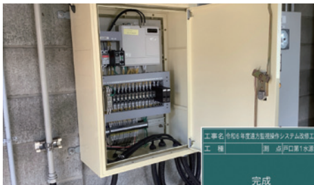
戸口第1水源地 完成
