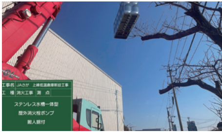
消火水槽搬入
