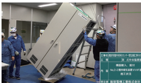
機器搬入状況
