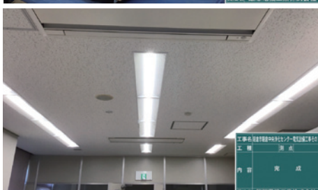
空調設備完成
