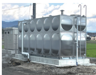
消火水槽据付配管 完了
