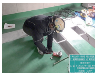
盤アンカー引張試験
