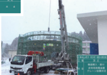
機器搬入 (クレーン設置)
