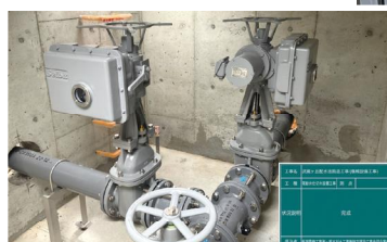
電動仕切弁設置状況
