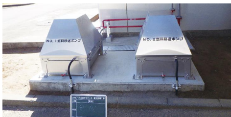
燃料移送ポンプ 完成
