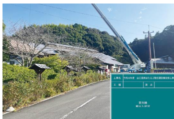
室外機搬入状況
