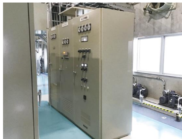
低圧受電盤・直流電源盤据付
