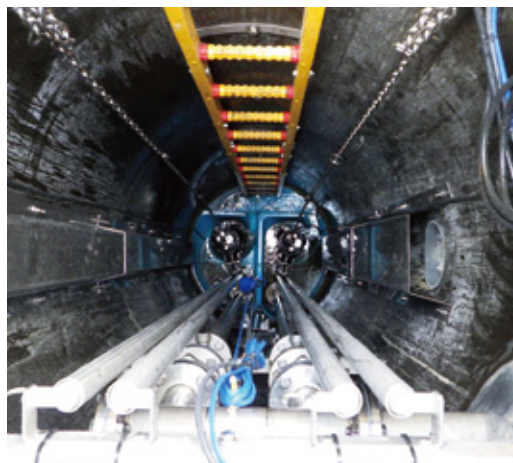
マンホール内部
