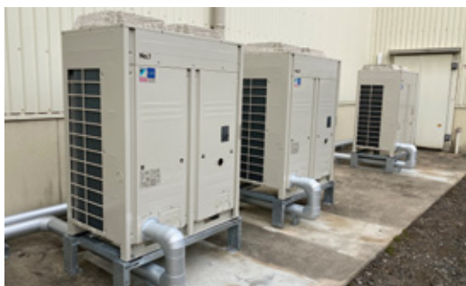
室外機据付状況
